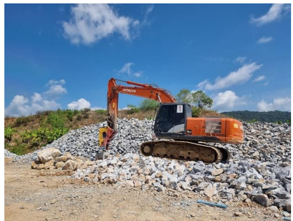
รูปที่ 2-11 การซ่อมแซมคันทำนบดินในช่วงหน้าแล้ง และเตรียมปลูกต้นไม้ในช่วงหน้าฝน
